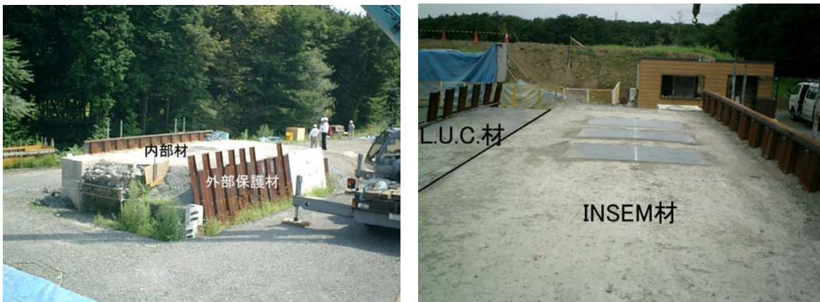
写真-2 左：実物大衝撃実験試験体、右：内部材天端部状況
